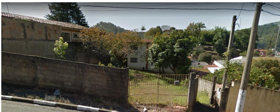
Figura 10 : Inexistência de calçada, falta de conservação e falta de acessibilidade.
