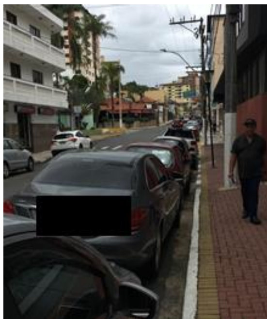
Figura 11: Calçada estreita com ocupação de postes de energia.
