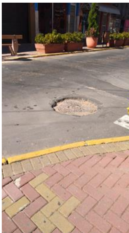
Figura 16: Rua com buraco e sem manutenção e conservação.
