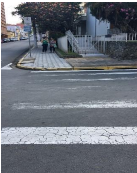
Figura 14: Falta de sinalização em um dos pontos do município.
