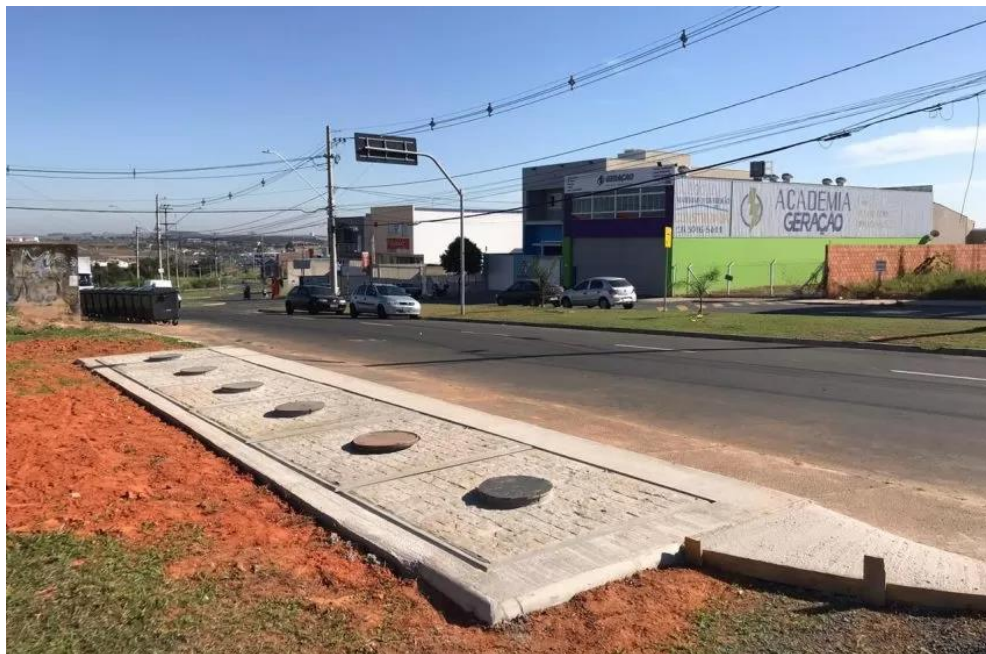
FIGURA 10 – Construção do ecoponto subterrâneo da cidade de Indaiatuba.
