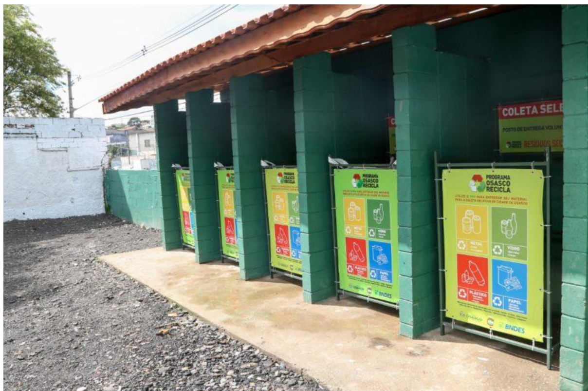
FIGURA 4 – Ecoponto de Osasco – SP.
