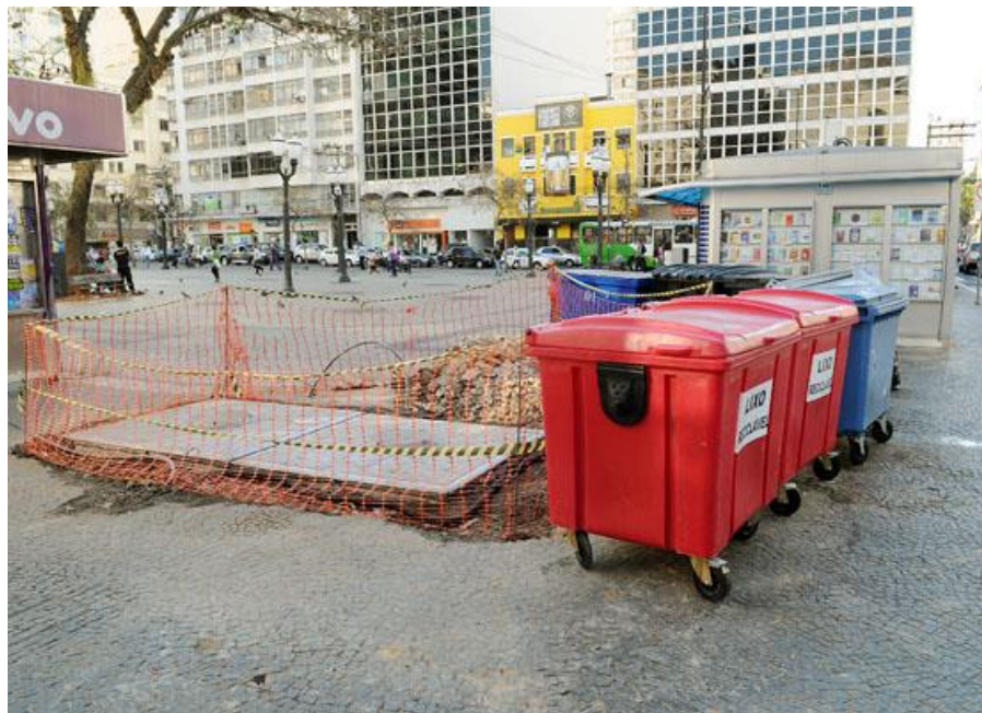
FIGURA 8 – Construção do ecoponto subterrâneo da cidade de Campinas.
